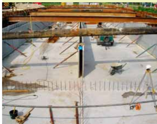
Aanleg van bergbezinkbassin in Zaltbommel
